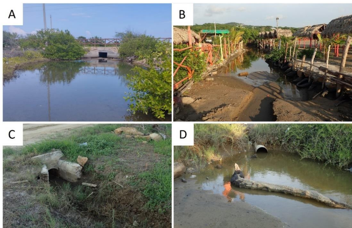
Figura 5-28. Canales y caños que se conectan con la playa de Puerto veleró y Caño dulce (A y B), canal de aguas lluvias en el sector de Caño Dulce (C y D). Fotos: Cristian Ruiz.
