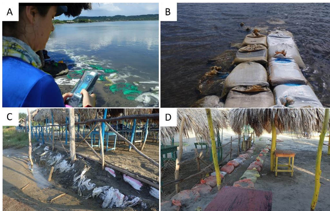
Figura 5-22. Rellenos de playa con sacos de arena en el sector de Puerto Velero (A, B) y sector de Caño Dulce (C, D). Fotos: Cristian Ruiz.
